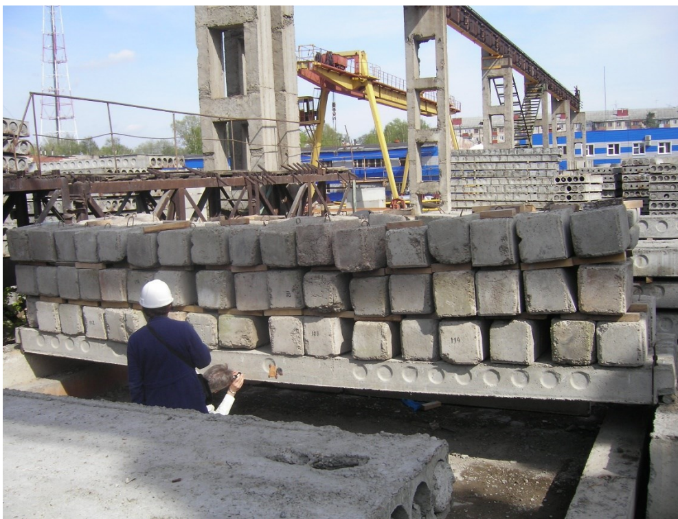
Рис. 3. Испытание плиты перекрытия на территории завода строительных конструкций «РАФФ», г. Казань Республики Татарстан
