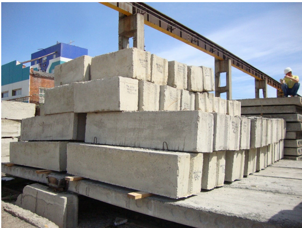
Рис. 4. Испытание ригеля на территории завода строительных конструкций «РАФФ», г. Казань Республики Татарстан
